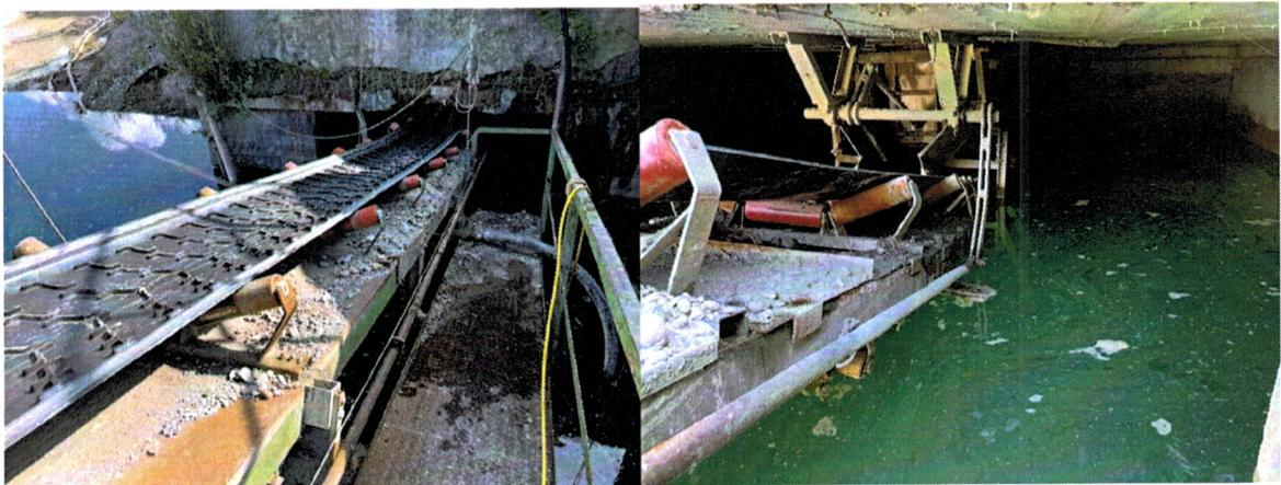
3. Für die Kieswäsche werden ca. 300 cbm Brunnenwasser je Stunde benötigt. Dieses Wasser wird über drei Druckpumpen aus dem unterirdischen Brunnen im Pumpenkeller gefördert. Durch die anströmenden Wassermassen wurde der Pumpenkeller geflutet und die Elektromotoren der Pumpen zerstört.
